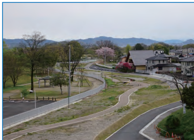
宮田導水路（改修後）
