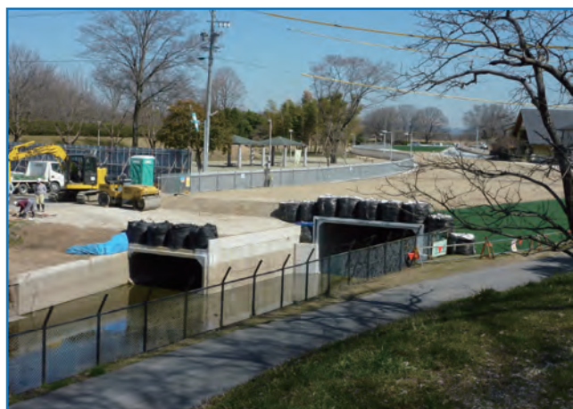
宮田導水路（改修前）
